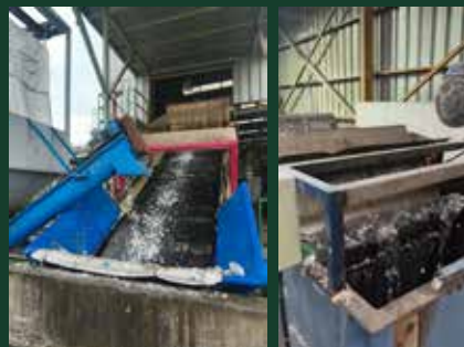
[Línea de molienda y lavado]
